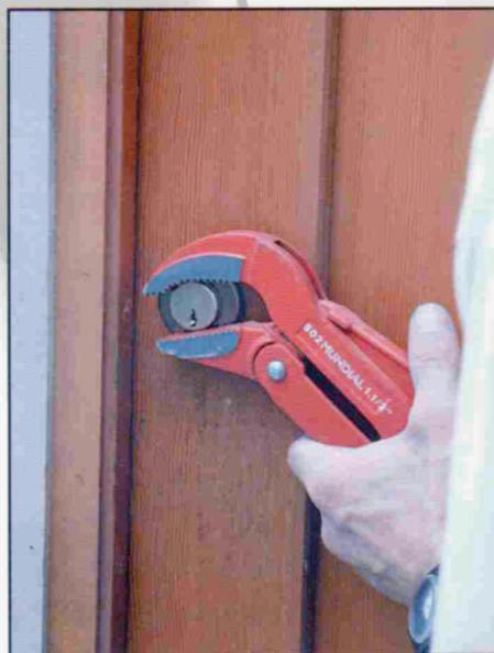
▶ Una serratura, il cui corpo sporge troppo dal piano dell'anta, può esser facilmente strappata per torsione.
