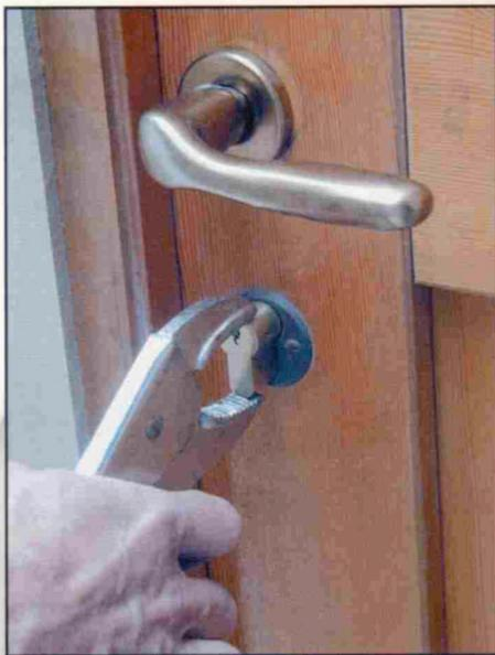
▶ Una serratura a cilindro, che sporge troppo dal piano dell'anta, può esser facilmente strappata per flessione.
